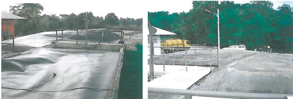
รูปแสดงบ่อหมักไม่ใช้อากาศแบบปิดฝาที่ใช้สร้างก๊าซชีวภาพ
