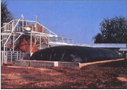
รูปแสดงบ่อหมักช้าแบบราง (Plug Flow digester)
