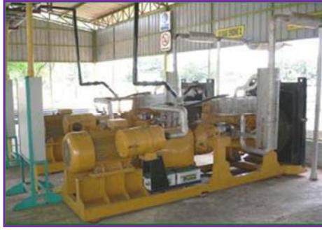
รูปแสดงเครื่องยนต์ตัดแปลงดีเซลใช้กับก๊าซชีวภาพรูปเครื่องยนต์ตัดแปลงเบนซินใช้กับก๊าซชีวภาพ
