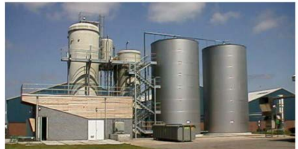
รูปแสดงลักษณะของระบบผลิตก๊าซชีวภาพแบบExtended Granular Sludge Bed
