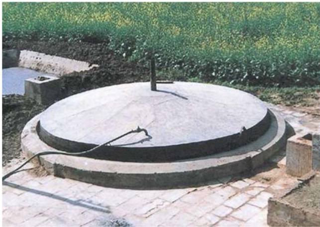
รูปแสดงบ่อหมักข้าวแบบถังลอย (Floating drum digester)
