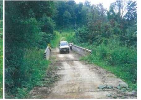
บริเวณแนวท่อส่งน้ำ
